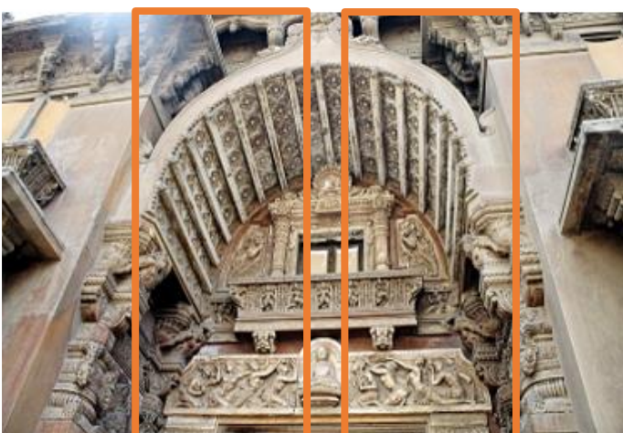
صورة ( 17 ) المدخل الرئيسي لقصر البارون تتميز بالتماثل وتأكيد المدخل بحائط زخرفي يخترقه العقد " مدخل مؤكد بعقد "
